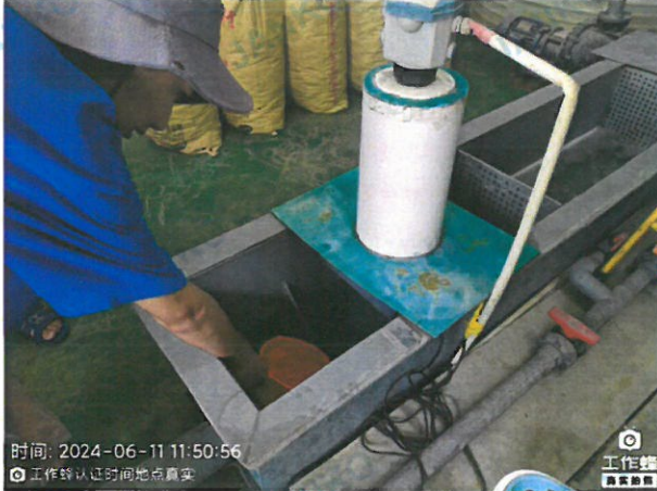
生产废水排放口 01
